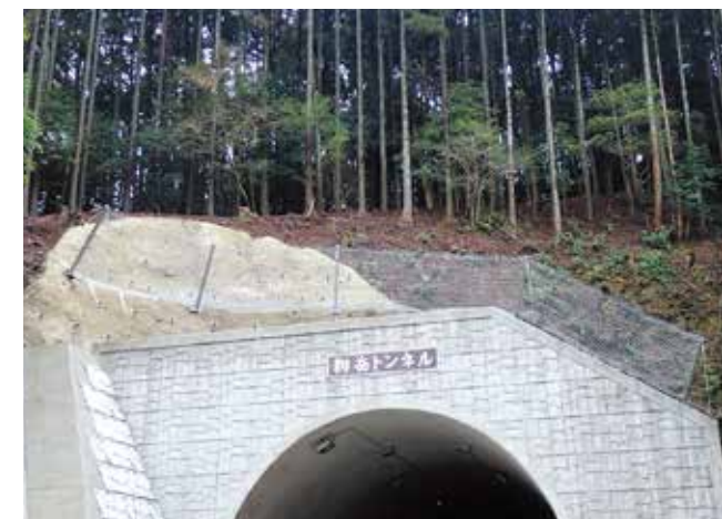
■ トンネル坑口への落石防止対策 福岡県 CFR-50 (Type-2)
