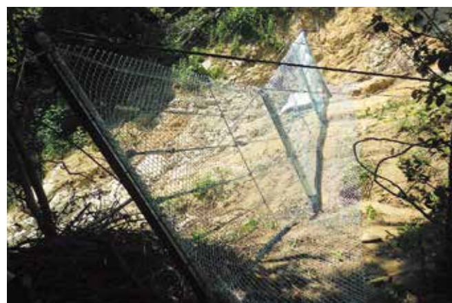
■ 上部掘削時の仮設落石防止柵として 広島県 CFR-50 (Type-2)
