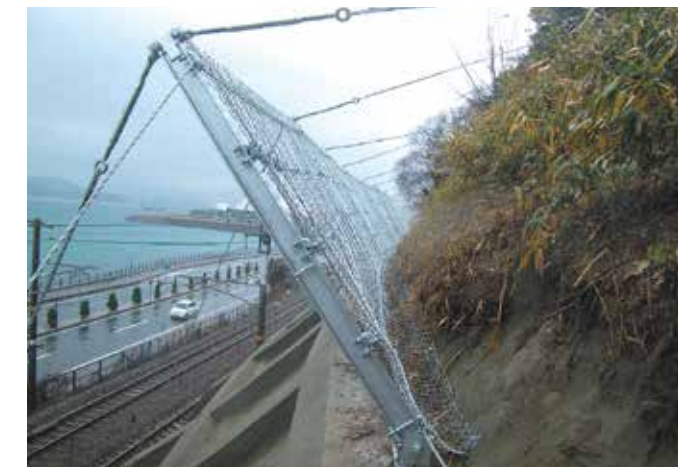
■ 下部線路への落石防止対策 山口県 CFR-50 (Type-1)
