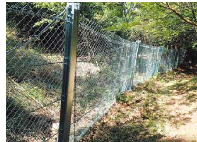
■ 歩道への落石防止対策 大分県 CFR-50 (Type-2)
