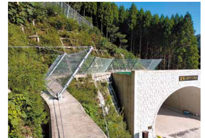
■ トンネル坑口への落石防止対策 大分県 CFR-50 (Type-2)
