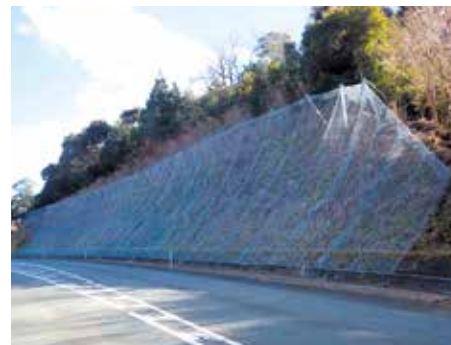
ポケット式落石防護網
