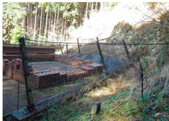
■ 文化財への落石防止対策 長崎県 CFR-50 (Type-1)
