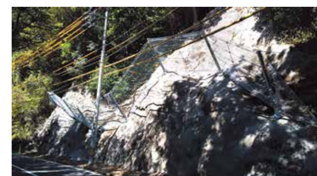
■ 変化の大きい法肩部への設置 島根県 CFR-50 (Type-2)
