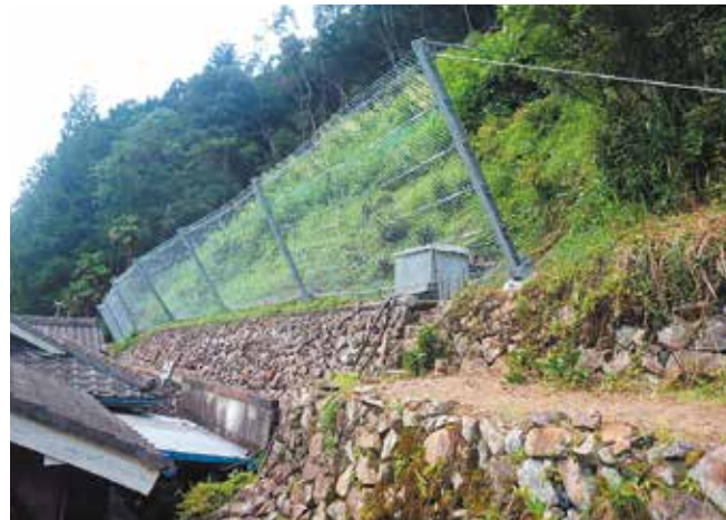
■ 民家への落石防止対策 和歌山県 CFR-50 (Type-2)
