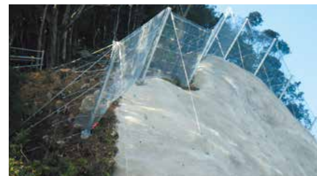
■ 起伏の激しい吹付法肩への設置 鹿児島県 CFR-100 (Type-1)
