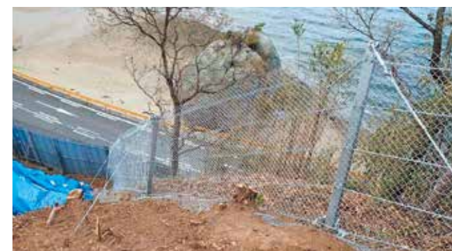
■ 高低差のある地山への設置 山口県 CFR-50 (Type-1)
