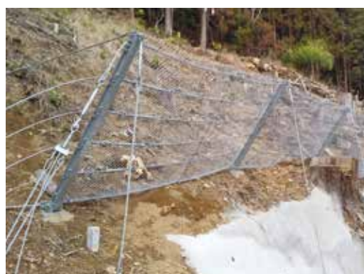
緩衝金具のすべり量を調整しネットの張り出しを2m程度に抑えることができます
