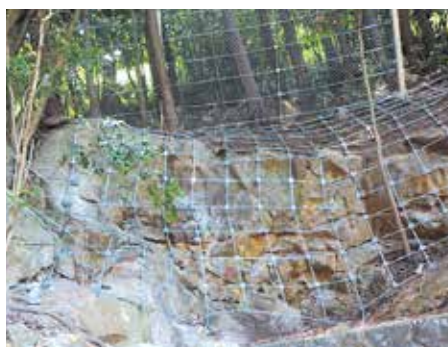
ロープ伏工 (クロスワイヤーネット)
