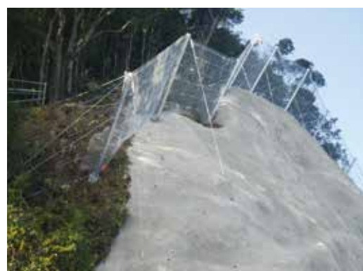
起伏の激しい法肩部にも設置が可能。施工場所の状況にも対応ができます
