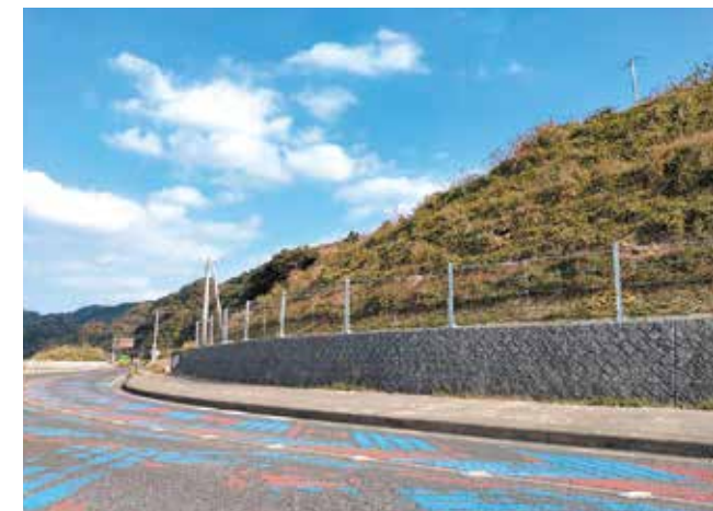
■ 道路に接した場所の落石防止対策 佐賀県 CFR-50 (Type-2)
