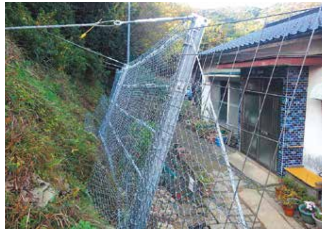
■ 民家への落石防止対策 長崎県 CFR-50 (Type-2)
