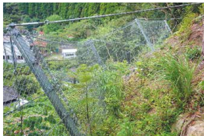
■ 法面中腹での落石防止対策 熊本県 CFR-50 (Type-1)
