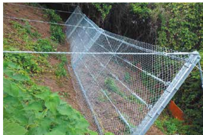
■ 急傾斜地中腹での落石防止対策 広島県 CFR-50 (Type-2)
