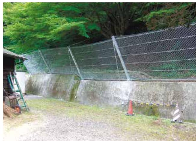
■ 構造物への落石防止対策 山口県 CFR-50 (Type-1)
