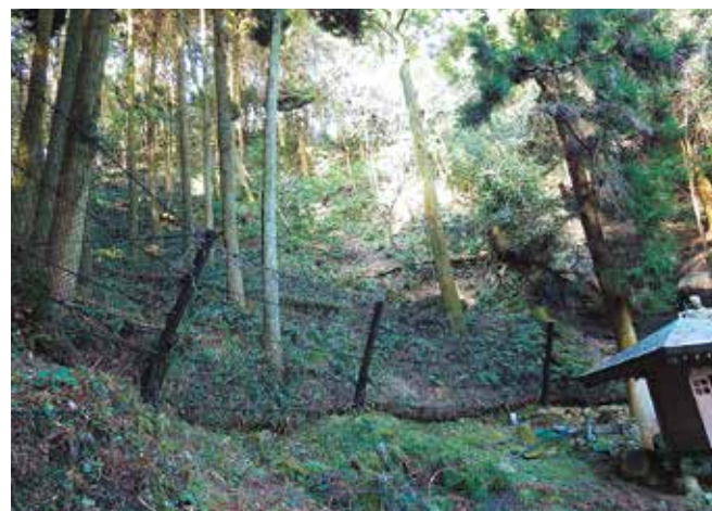
■ 寺院構造物への落石防止対策 佐賀県 CFR-50 (Type-1)
