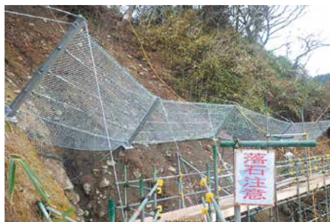
■ 安全通路使用者への落石保護対策として 熊本県 CFR-50 (Type-1)
