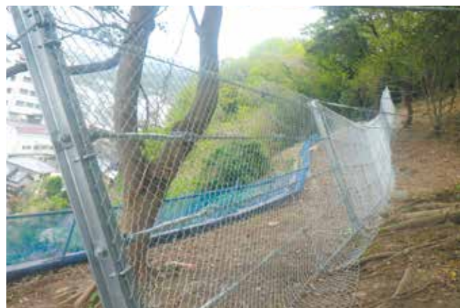
■ 法面中腹での落石防止対策 長崎県 CFR-50 (Type-2)
