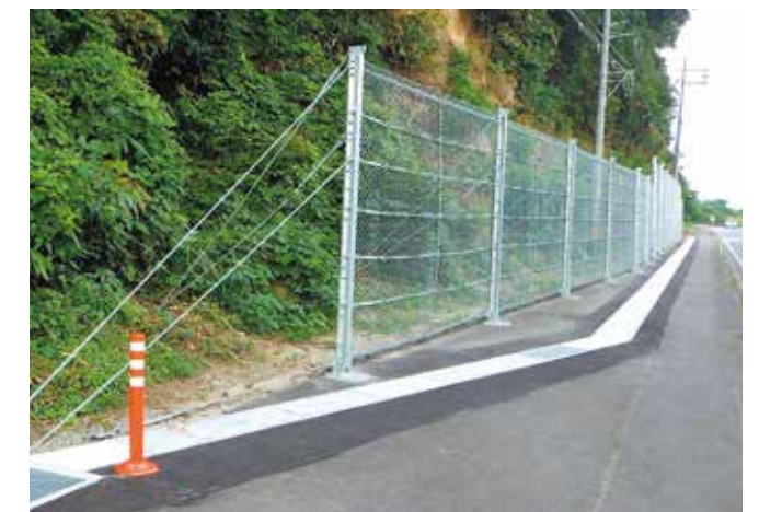
■ 道路に接した場所の落石防止対策 島根県 CFR-50 (Type-2)
