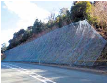
ポケット式落石防護網
