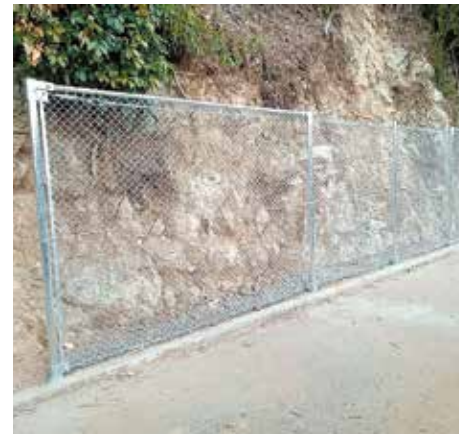
背面の斜面が迫った法尻
