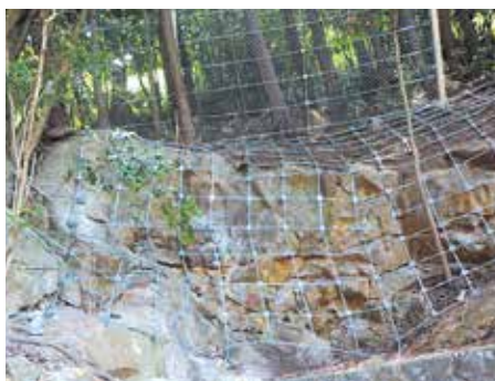
ロープ伏工 (クロスワイヤーネット)
