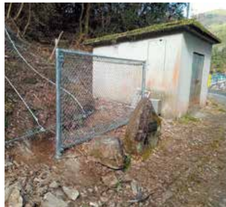
防護網の隙間に設置
