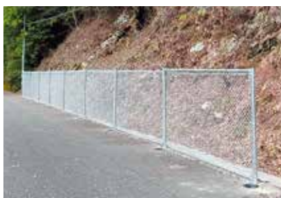
道路際の落石対策
